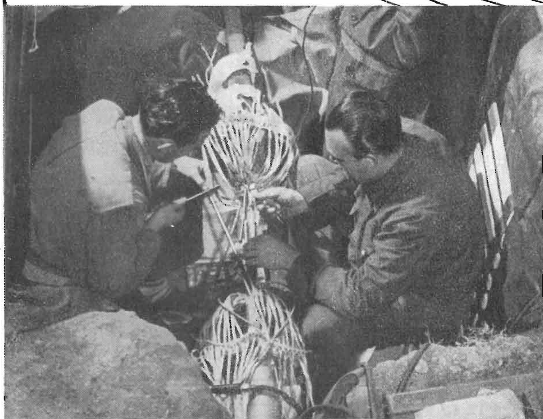
ESECUZIONE DI GIUNTO SU CAVO COASSIALE
